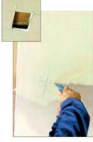
Si es necesario, marcar y abrir los huecos para las cajas, previamente a la colocación del panel.
