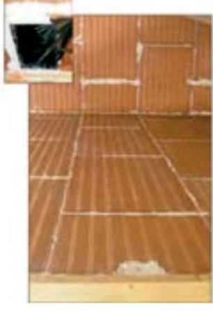
La pared de ladrillo cerámico Megabrick de NOVACERAMIC permite la colocación de panel de cartón-yeso. Las cajas deben sobresalir el espesor de la placa para conseguir un acabado final a nivel.
