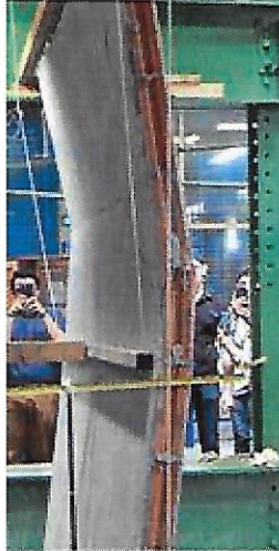
Figura 7. Condición de falla del muro 1 MEGABRICK 8 (25-50-8)
